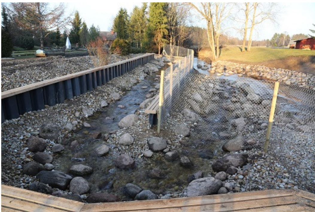
Foto 4. Karilatsi kalapääsu alumine osa 25.12.2013. Hinnanguline vooluhulk 0,1–0,15 m 3 /s (R. Järvekülg; 25.12.2013).
