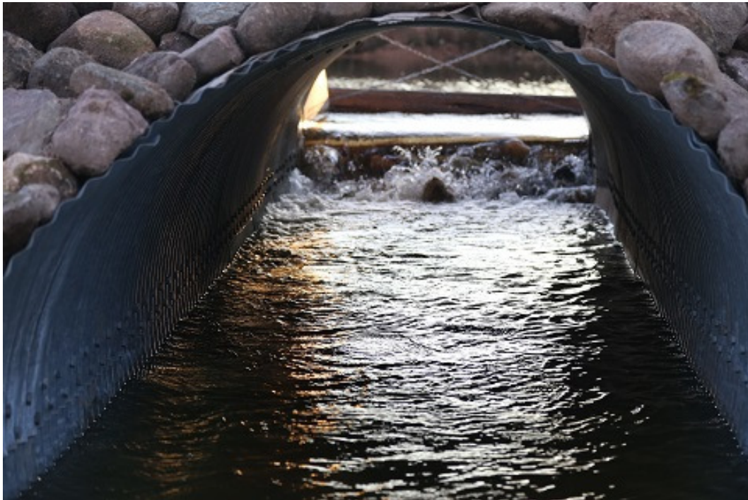
Foto 7. ... muidu tuleb kalapääsu sissevool ülaveetaseme hoidmiseks tõkestada laudvarjadega. Selliselt pole aga kalapääs kaladele enamiku aastast läbitav. Varjade eemaldamise korral alaneks aga üleveetase ning kalamajandi veevarustus ei toimiks enam isevoolselt (R. Järvekül; 25.12.2013).
