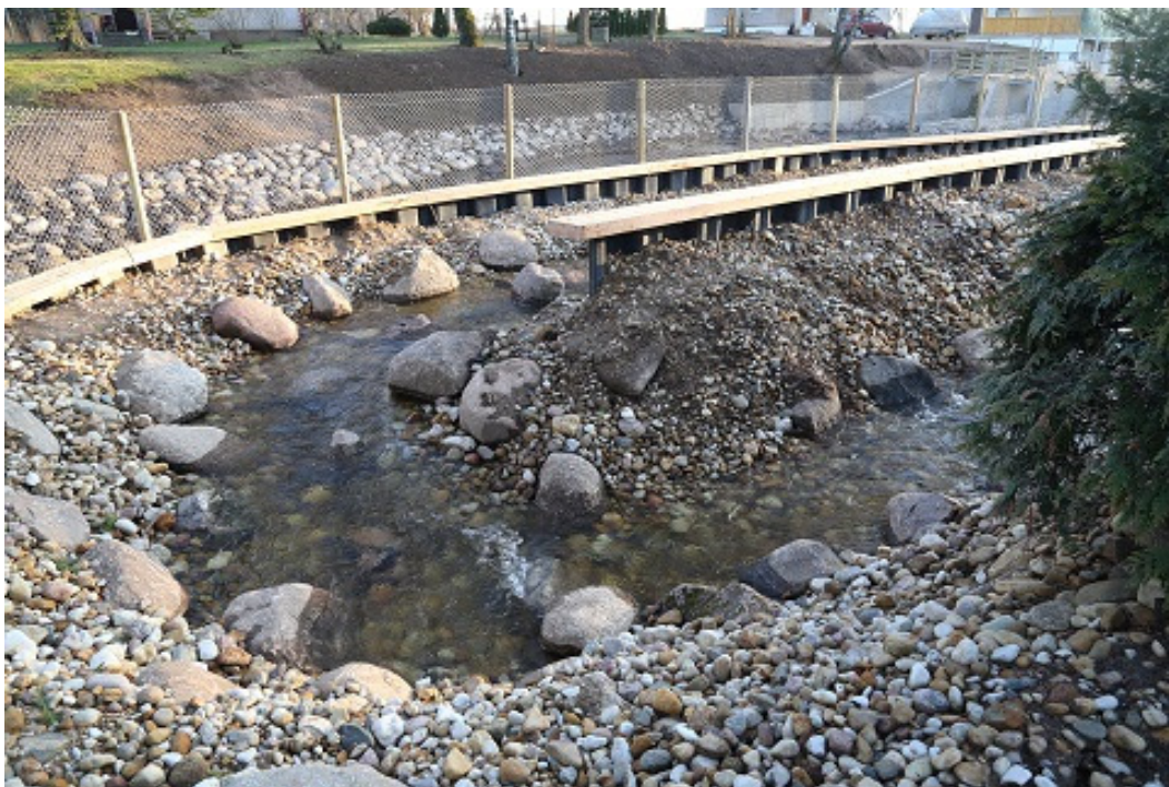
Foto 5. Karilatsi kalapääsu keskosa, parem-tagasikäänu kohal. Hüdraulilised tingimused on kalapääsus kaladele soodsad. Ka väikeste vooluhulkade korral on kalapääs kaladele põhimõtteliselt läbitav (R. Järvekülg, 25.12.2013).
