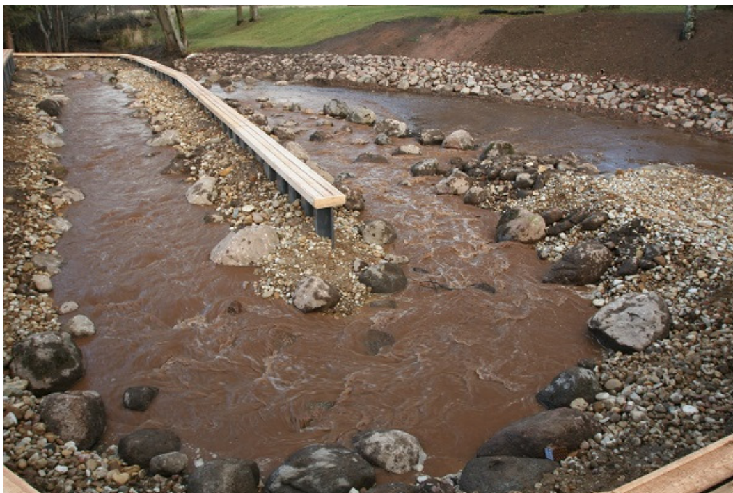
Foto 3. Karilatsi kalapääsu alumine osa enne suubumist Leevi jõkke. Vesi on sogane, kuna kalapääsu sissevoolu eest on just kõrvaldatud pinnastamm ning vesi just kalapääsu sisse lastud. Hinnanguline vooluhulk kalapääsus 0,3–0,4 m 3 /s (R. Järvekülg; 29.10.2013).
