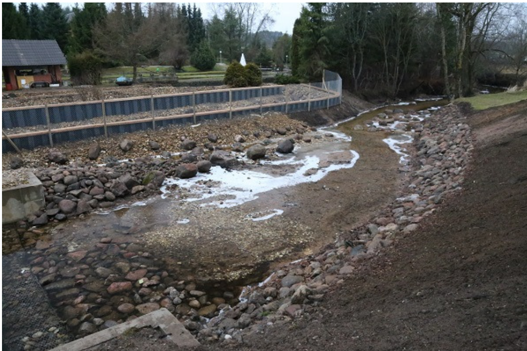
Foto 5. Leevi jõgi Karilatsi paisu all. Esiplaanil liigveelasu all olev jõesäng. Vasakult kaldalt siseneb jõkke kalapääsu väljavool (R. Järvekülg, 16.12.2013).
