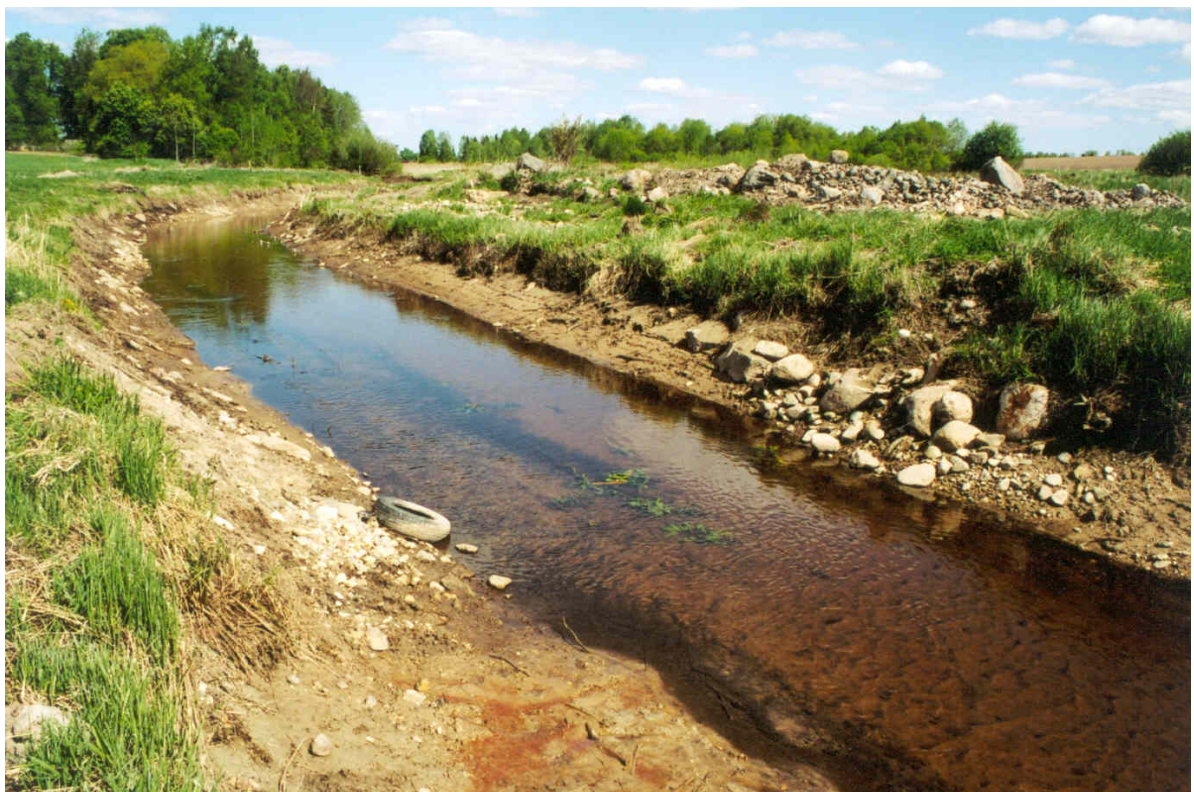
Foto 4. Peale kraavi puhastamist on põhi liivane ja lame. Siia on planeeritud rajada enne Rahinge paisjärve settetiik, et pidurdada setete allakandumist paisjärve.
