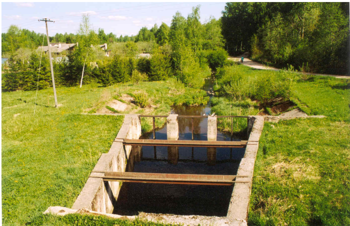
Foto 1. Ropka paisu lüüsregulaator vajab korrastamist
