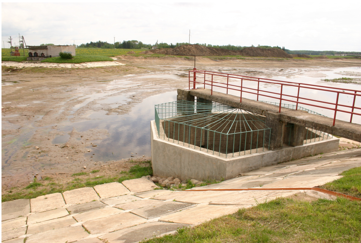
Foto 12. Rahinge paisjärve lüüsregulaator veehoidla peale korrastamist.
