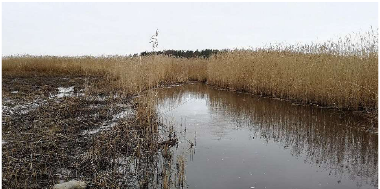
Foto 38. Riguldi jõe suudmeosa sängi kaevetööde lõppkoht. Vaade mere suunas – avaveeline voolängi osa mereni puudub, merelahe avavee osast lahutab kaevatud sängi 20-30 m laiune pillirooväli. Nagu näitasid 2020. a uuringud on suue kaladele praegu avatud, aga pilliroovälja ette on hakanud kogunema uuesti setted. Vajalik oleks täiendavalt lahti kaevata kuni 78 m pikkune sängiosa (R. Järvekülg, 13.12.2018).
