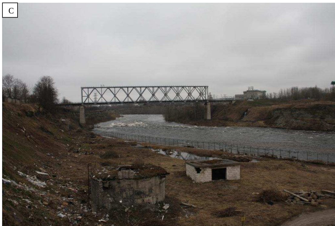
Foto 2. Vaade Kalda tn 16 kinnistu piirkonnast allavoolu. Fotel a - tavapärane situatsioon, fotol b - vooluhulk jões suurusjärgus 200-250 m 3 /s (avatud oli 1 paisu varjadest), fotol c - vooluhulk jões suurusjärgus 400-500 m 3 /s (avatud oli 2 paisu varjadest). Fotod: M. Öövel, J. Öövel ja R. Mõtlep.
