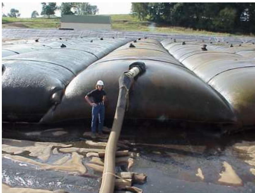
Foto 1 Geotuubide täitmine ladestusplatsil
