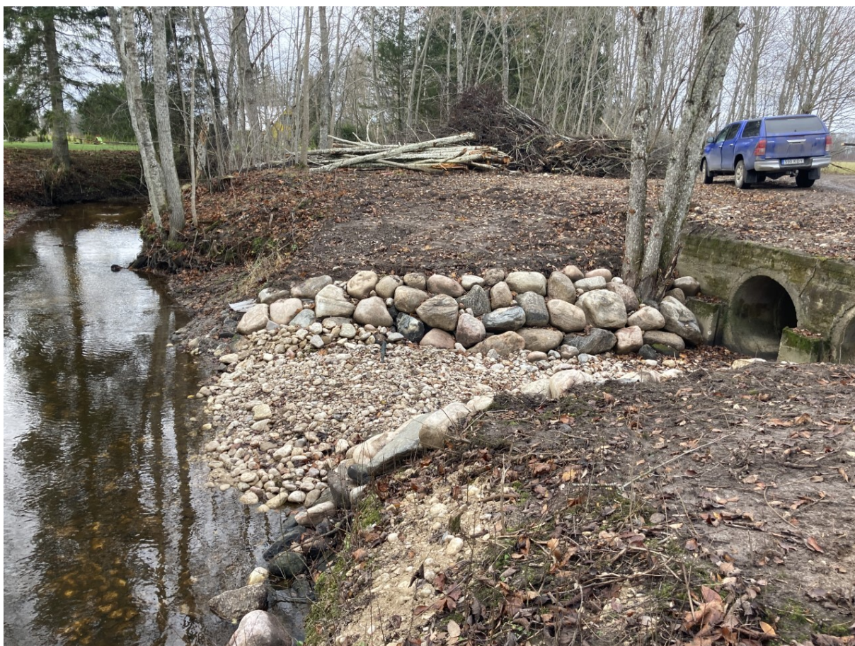
Foto 4. Foto vasakus servas voolab Kloostri jõgi ning esiplaanil on tõstetud sängipõhjaga Piskjõe peakraavi sissevool (M. Kesler 26.09.2022).
