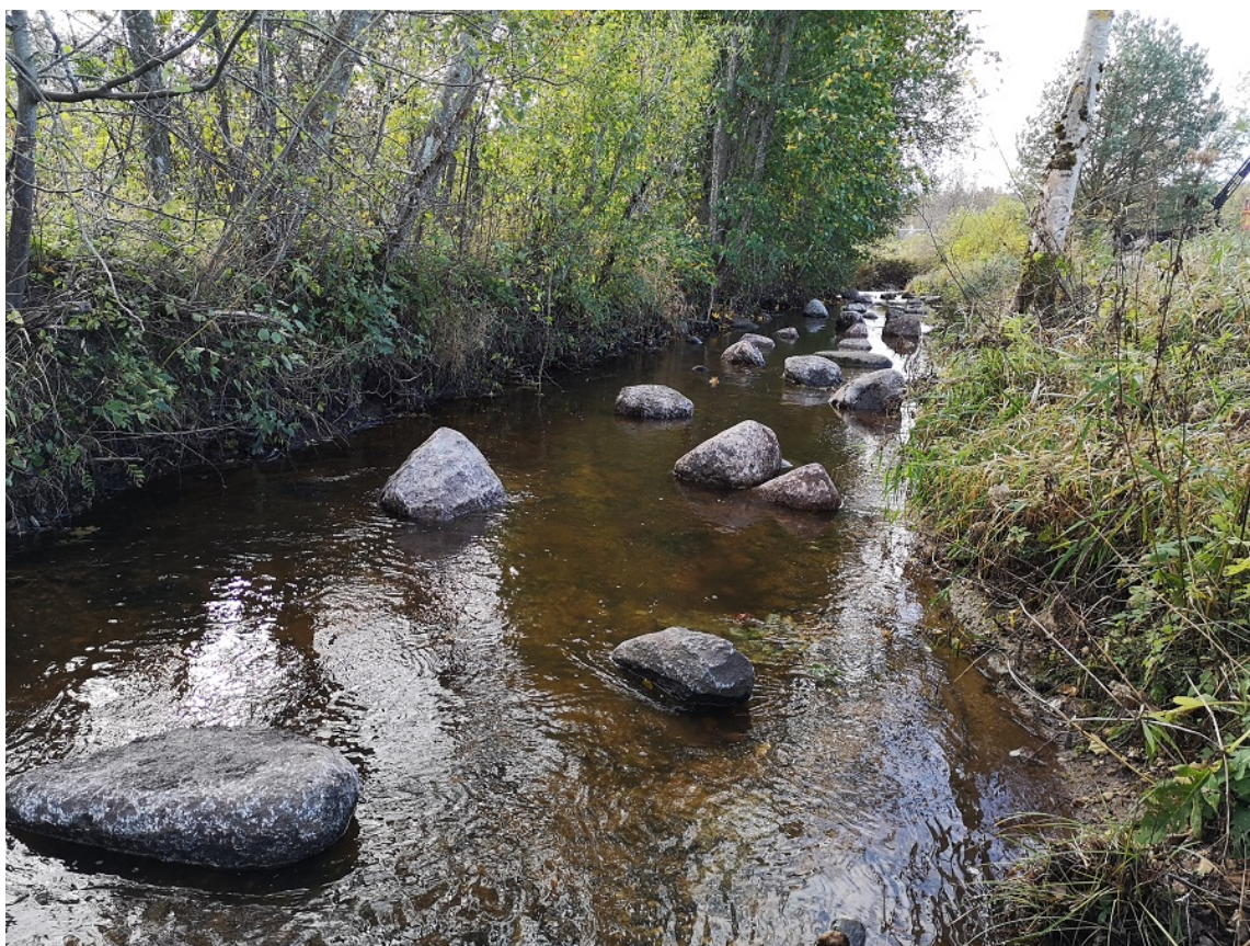
Foto 3.7.5. Timmkanal 0,4 km suudmest, pärast parendustööde läbiviimist (vaade allavoolu). Kivid on lisatud kanali sāngi 14.10.2020 (Foto: Rein Järvekülg).
