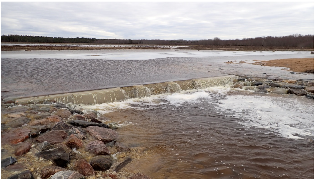
Foto 3.6.3. Töötav (paisutav) regulaator. Esimest korda paigaldati regulaatorile varjed ette 2021. aasta märtsi alguses. Regulaator koos kalapääsuga tagab olukorra, kus on võimalik osaliselt vett paisutada, kuid samas on tagatud kalade liikumine mere ja koelmuala vahel. Varjed eemaldatakse järk-järgult juuni esimeses pooles. (Foto: Roland Svirgsden, 03.03.21)
