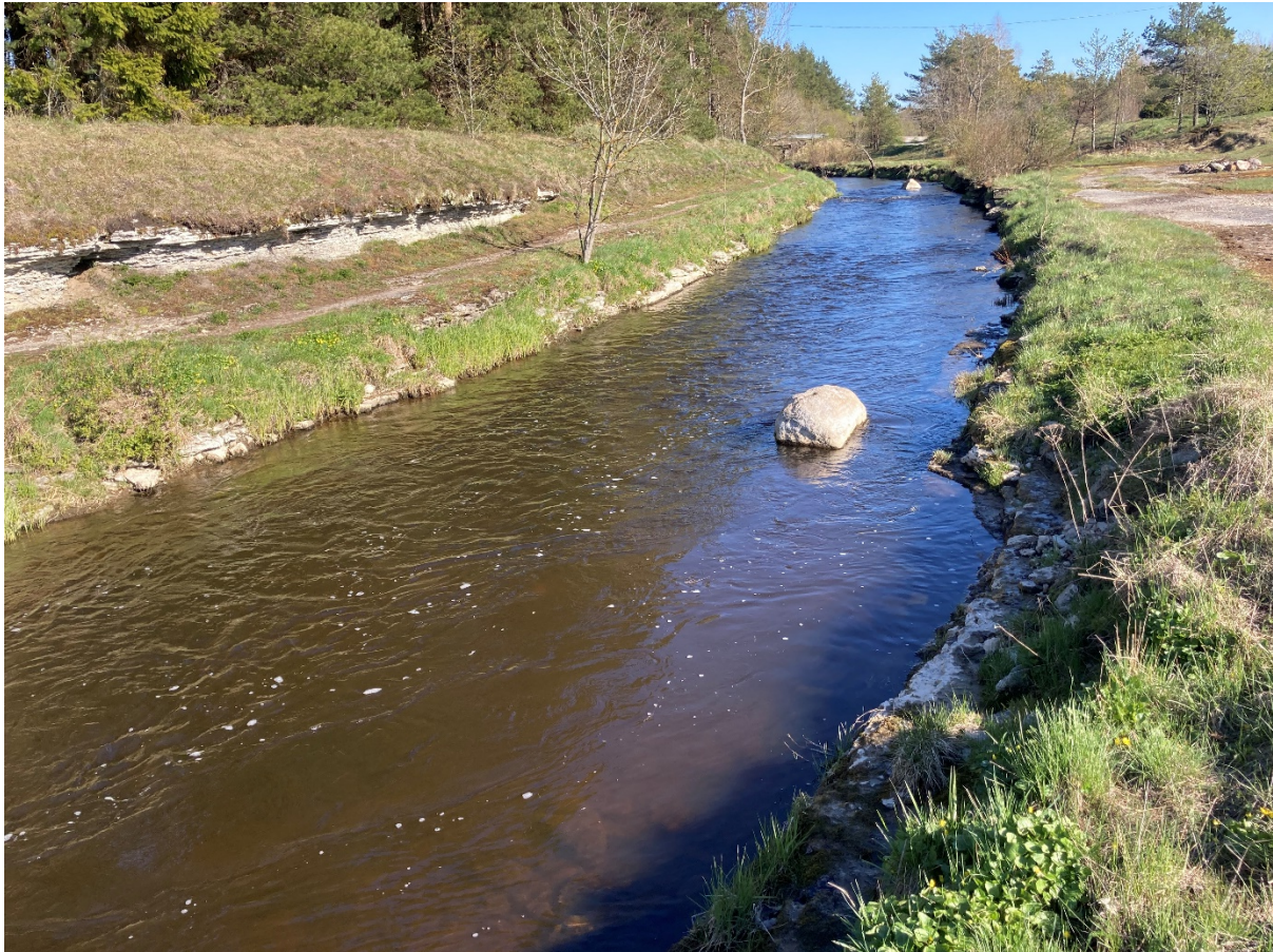
Foto 3.9.3. Parendatud jõelõik Vahikülas 08.05.2023. Valdavalt monoliitset paekivist põhjasubstraadiga kanali asemel esineb fotol nähtavas lõigus parendustööde tagajärjel oluliselt mitmekesisema põhjasubstraadiga elupaikasad (Foto: Martin Kesler).
