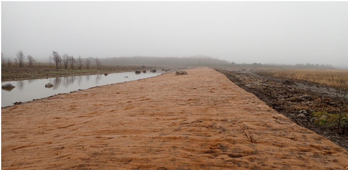
Foto 3.6.1. Äsja valminud pinnasvall (30.10.20). Pinnasvallist vahetult paremale jääb vana kivivall. Pinnasvalli ehitamiseks kasutati kohapealset pinnast ning sellest tulenevalt on valli maismaa poolse külje ette moodustunud veega täitunud süvend. Väinameri jääb antud fotol paremale ning Teorehe järv vasakule. (Foto: Roland Svirgsden)
