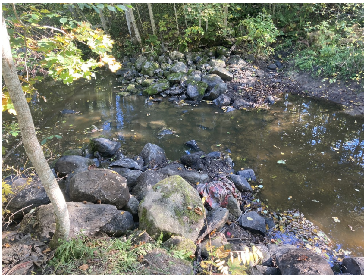
Foto 6. Esiplaanil on lammutatud Männiku paisuvare (M. Kesler 26.09.2022). Varasemalt oli kivivall kaladele ületatav ainult veerohkel perioodil.
