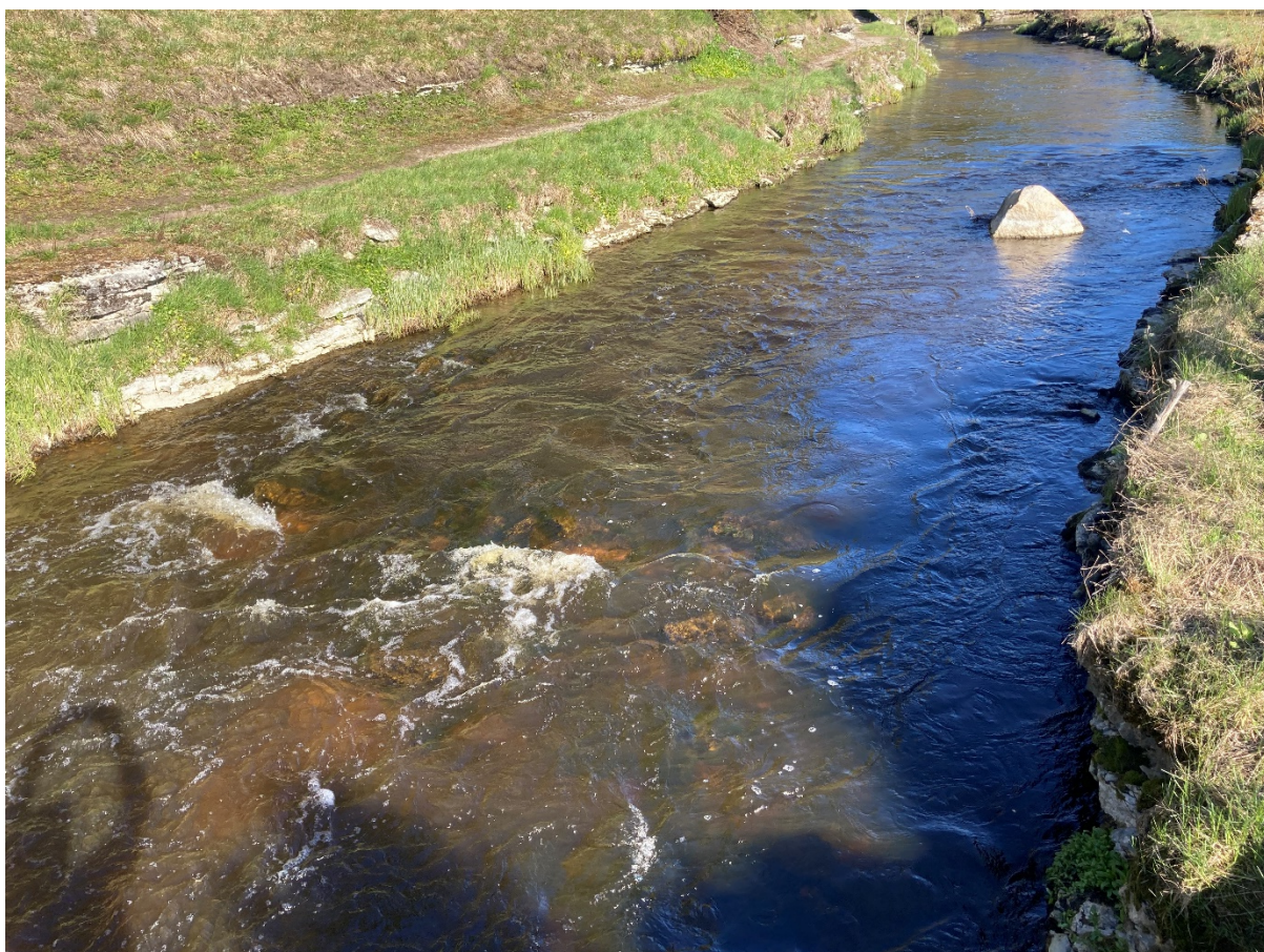
Foto 3.9.2. Parendatud jõelõik Vahikülas 08.05.2023. Monoliitsest pækivist põhjasubstraadiga kanali asemel esineb piirkonnas parendustööde järel mitmekesise põhjasubstraadiga elupaikasid (Foto: Martin Kesler).
