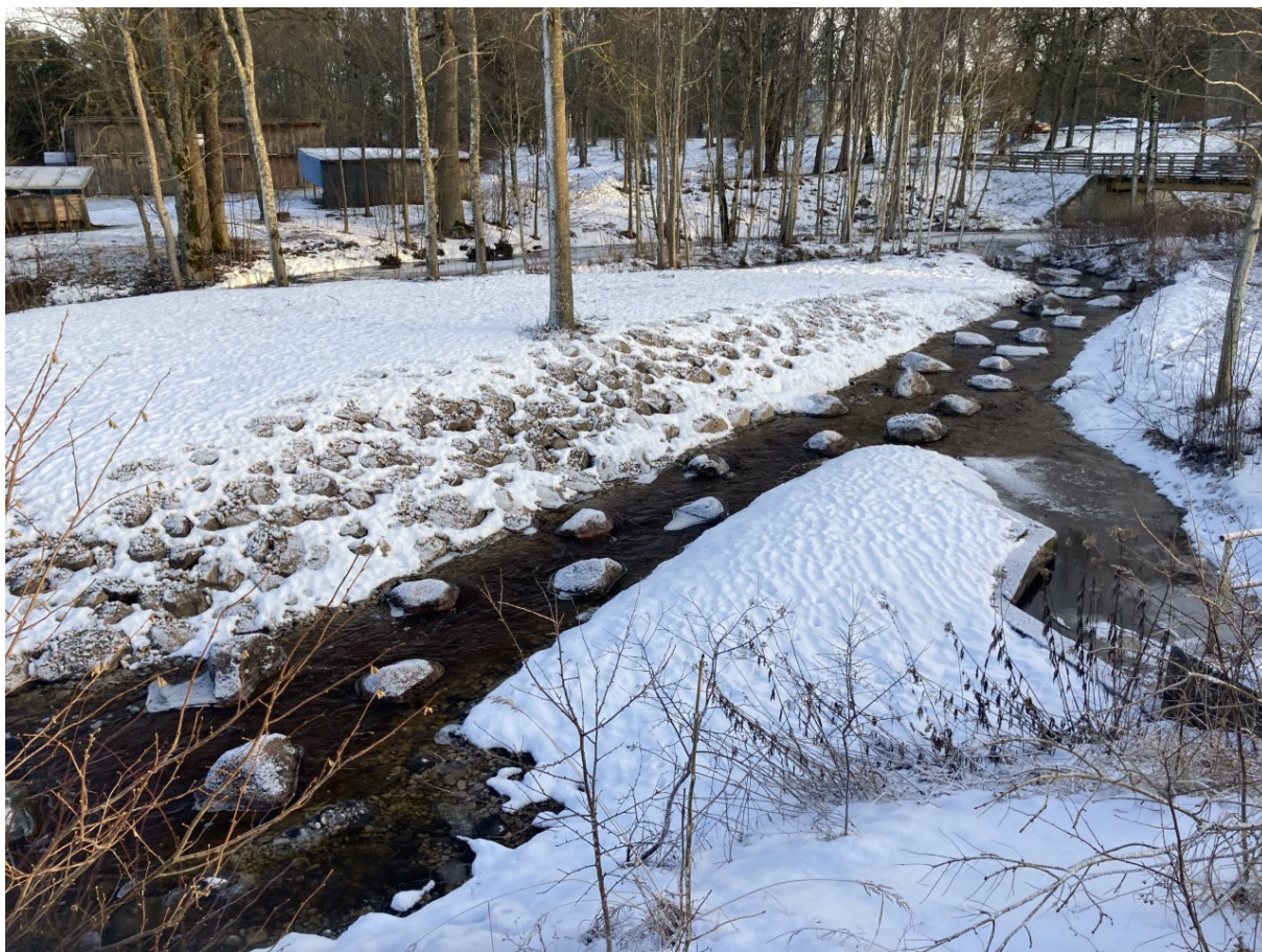
Foto 5. Vaade Laheosa paisu kõrvale rajatud uuele sängile. Kivine ja kruusane lõik on looduslähedase ilmega ning sobiv ka forelli koelmuks (M. Kesler 25.12.2022).
