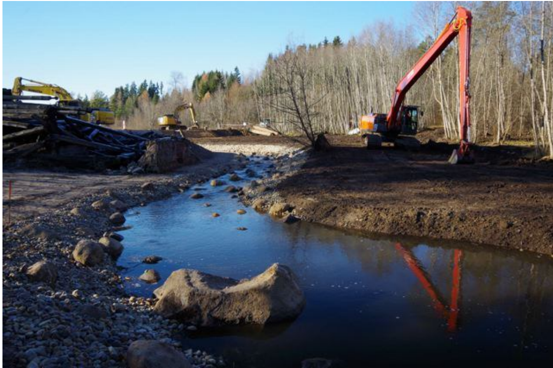
Foto 1. Vastuvoolu vaade Kaska I paisu asemele kujundatud kärestikule.
