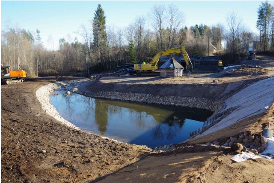
Foto 3. Allavoolu vaade Kaska I paisu asemele kujundatud kärestikule Põlgaste-Hurmi tee tammilt. Esiplaanil paistiik, mille täitumine settega on pildiltki märgatav.
