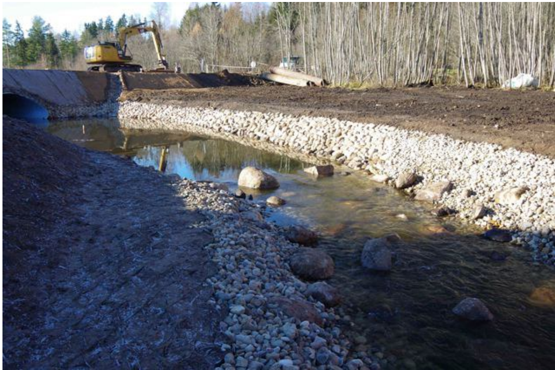
Foto 2. Vastuvoolu vaade Kaska I paisu asemele kujundatud kärestiku ülemisele osale. Taamal Kaska II paisu ehk lagunenud binokkeltruubi asemele paigaldatud truup. Pildil vasakpoolsel kaldapealsel geokärjele rajatud sängilaiend suurvee läbilaskmiseks.
