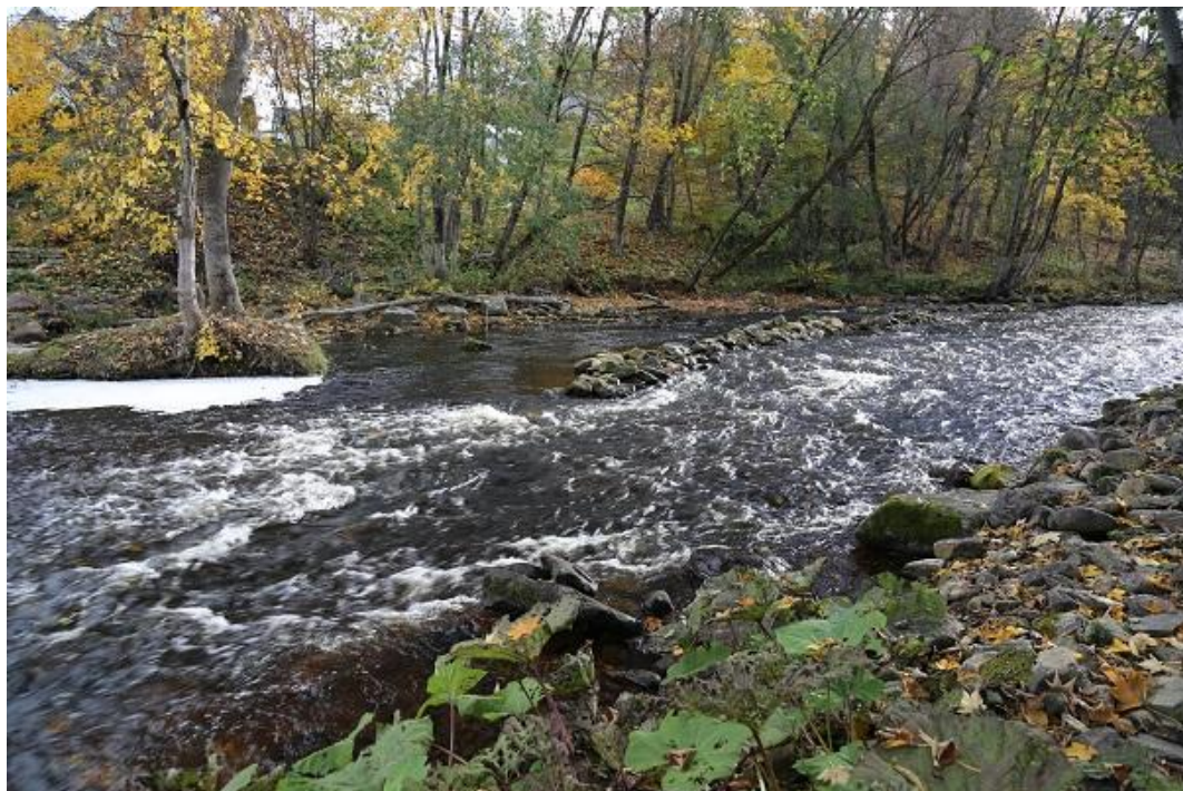
Foto 12. Kunda jõgi Lontova sillast 0,1 km ülesvoolu. Kiviviiru ladumisega on püütud veevoolu paremkaldast, kuhu hiljuti on rajatud kohvik, eemale suunata. 2012. a kevadel oli jõe kaldale rajatud kohvik üleujutuste küüsis ... (R. Järvekülg, 11.10.13).
