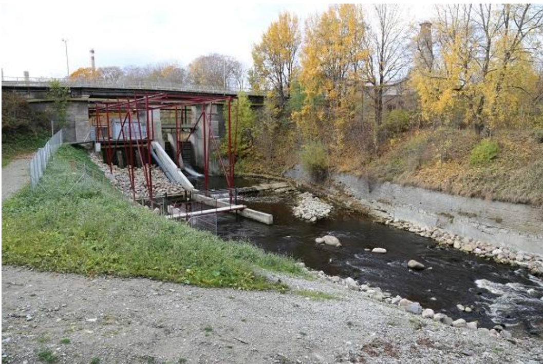
Foto 22. IMG Energy AS pais 2,83 km kaugusel jõe suudmest. Paisu kõrgus ca 4 m. Paisu juurde rajati 2013. a algul kalalift. Seisuga 01.12.13 kalalift töötanud veel pole (R. Järvekül, 11.10.2013).
