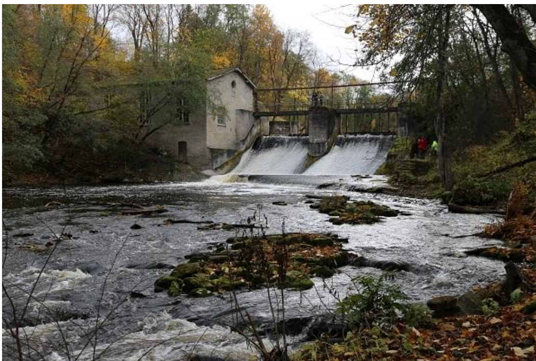
Foto 17. Kunda HEJ pais 2,3 km jõe suudmest. Veetasemete vahe paisj juures on ca 7 m. Kunda HEJ rajati 1893. a. Viimane taaskäivitamine toimus 2000. a. Viimased paar aastat pole jaam töötanud (R. Järvekülg, 11.10.13).
