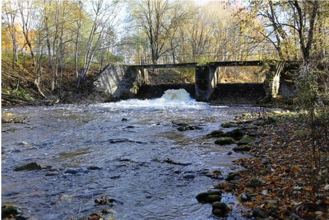
Foto 29. Kunda mõisa pais 5,5 km suudmest. Paisu paisutuskõrgus uuringute ajal oli 2,05 m (R. Järvekül, 11.10.13).
