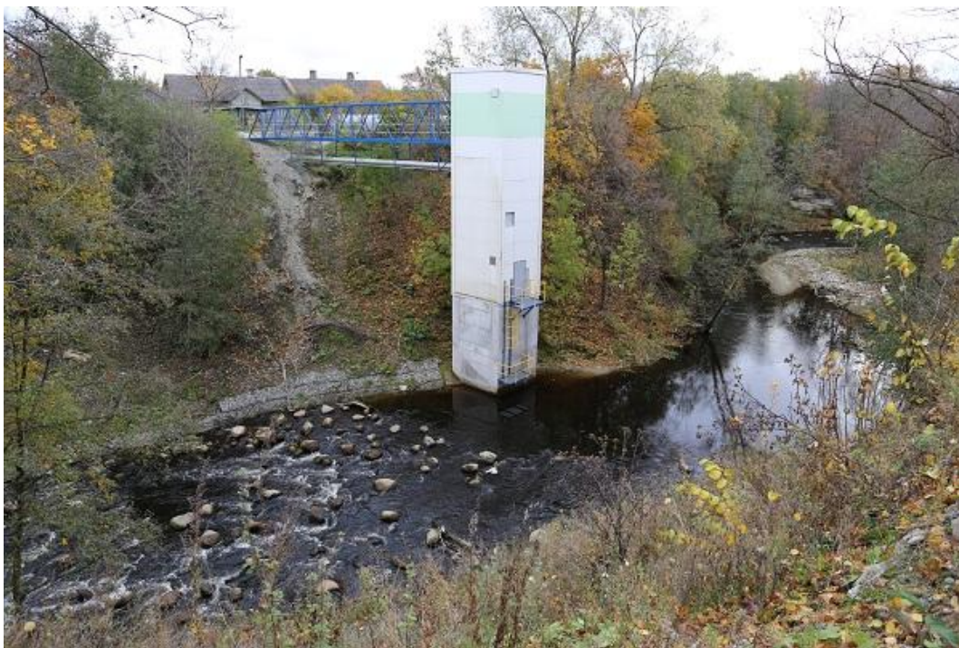
Foto 20. Kunga jõgi 2,65 km suudmest. Estonian Cell AS veehaare koos paisuga rajati aastatel 2005–2006. Samaaegselt paisu valmimisega alustati EL ÜF tehnilise abi projekti raames projekteerimistööid rajatava paisu likvideerimiseks ja asendamiseks kärestikuga. 2011. a asendatigi pais kärestikuga. Vaade tehiskärestiku ülaosale (R. Järvekülg, 11.10.13).
