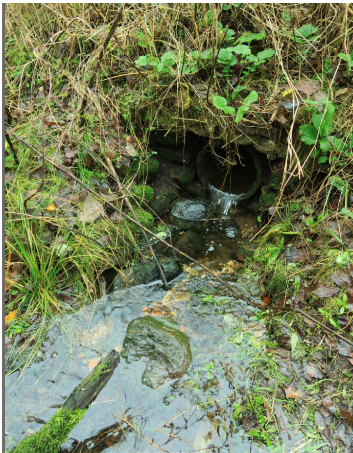
163. Kraavi otsast kümmekond m edela pool 20 cm läbimõõduga betoontoru. Toru põhi oli 5 cm kraavi veetasemest kõrgemal. Vesi voolas solisedes välja:
