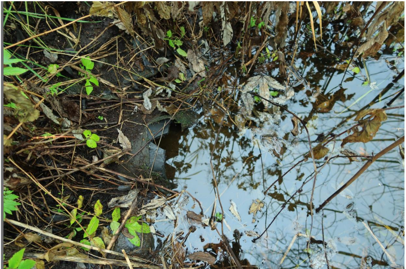
157. Kraavi vasakul kaldal 15 cm läbimõõduga must plasttoru. Oli poolenisti setet täis ning sette peal paar cm vett. Voolu ei olnud. Kraavi vesi oli torusse valgunud:
